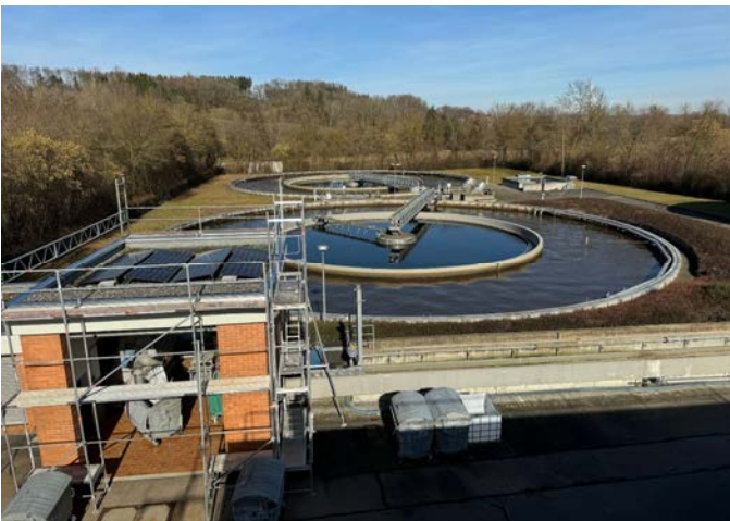
Klärwärter Roland Butz u. BM Karl Hauler besichtigen die Anlage
