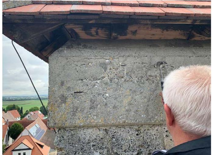
Um zu verhindern, dass diese irgendwann abplatzen und nach unten stürzen, muss die Betonoberfläche neu aufgebracht werden.
